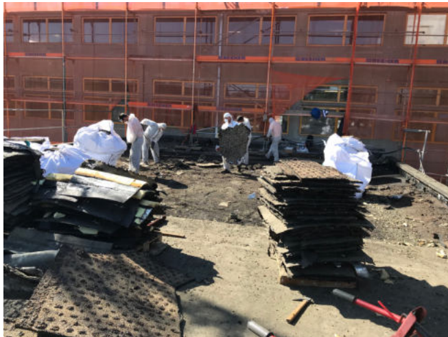
Altlastensanierung Dach
