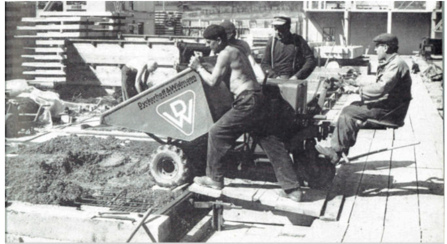
Baustellenfertigung der Deckenplatten
