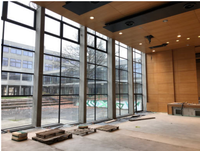
Fassade mit Rauchabzügen
