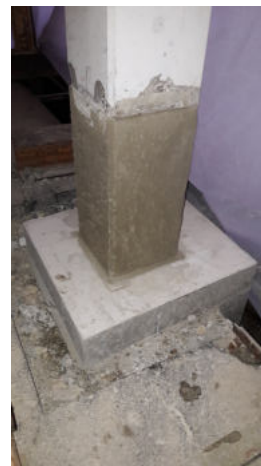
Reprofilierung der Stützen
