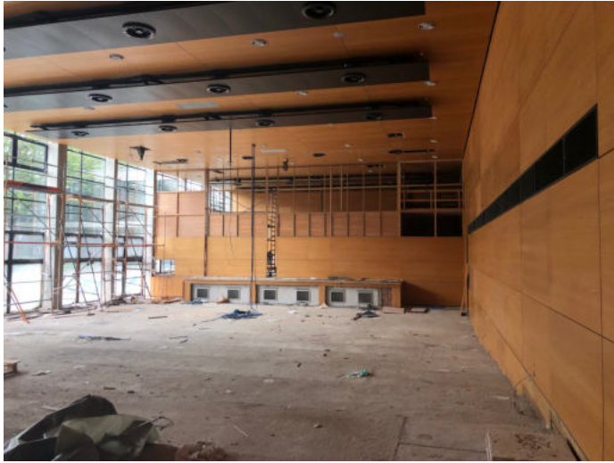
Wiedereinbau Wand- und Deckenverkleidung Aula
