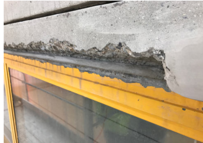
Entrosten und Rostschutz der Bewehrung
