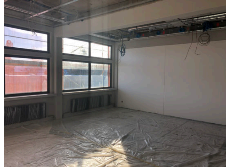
Reinigung und neue Beschichtung
