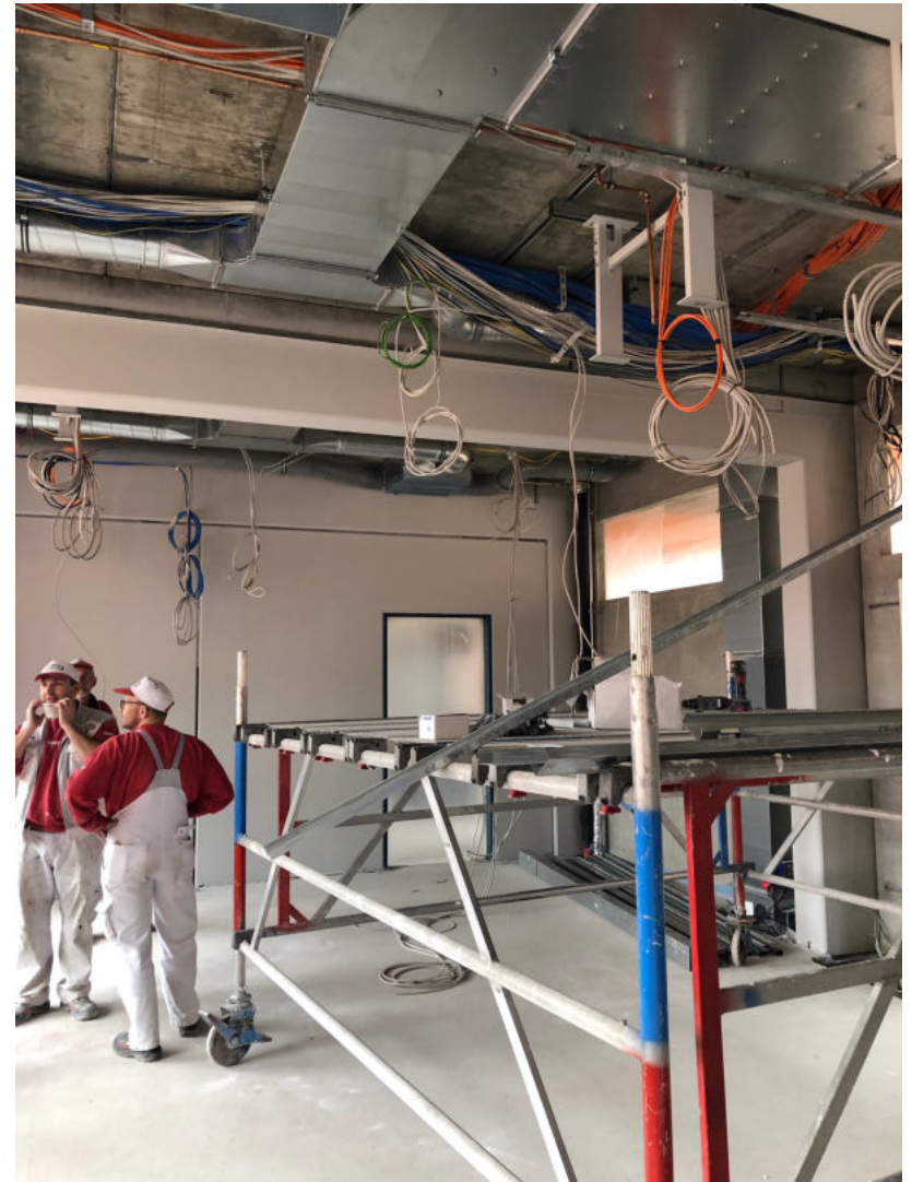
Lüftungsinstallation in vorhandener Struktur
