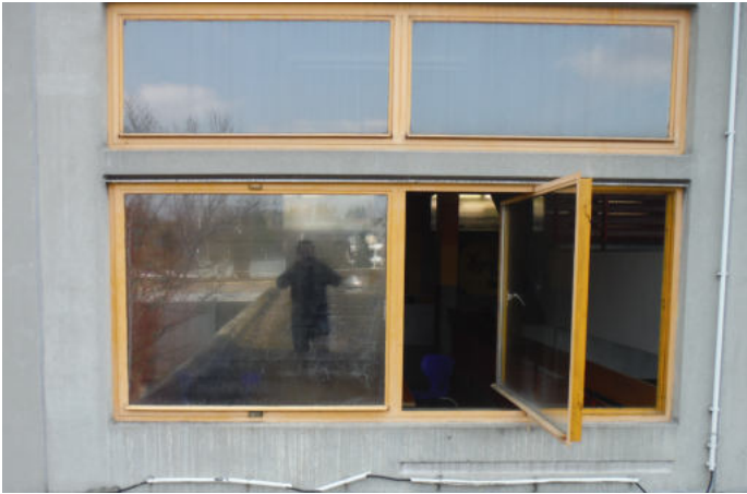
Bestand: gelb lackierte Bestandsfenster mit Drehflügel
