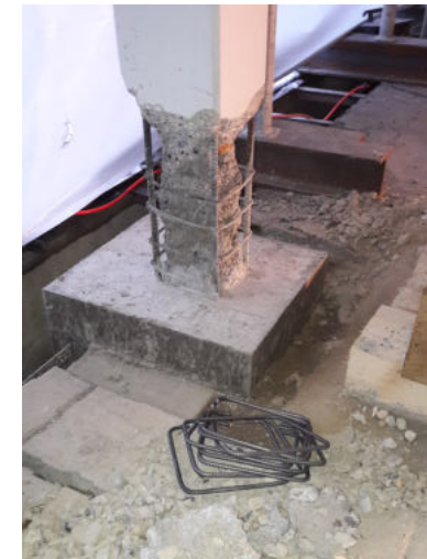
Betonnage neuer Stützenfüße
