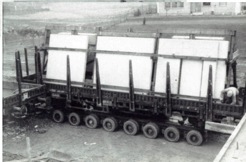
Transport von Innenwandplatten mit Straßenroller der Bundesbahn
