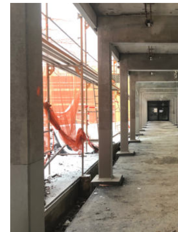
Schutzbeschichtung der Stützen
