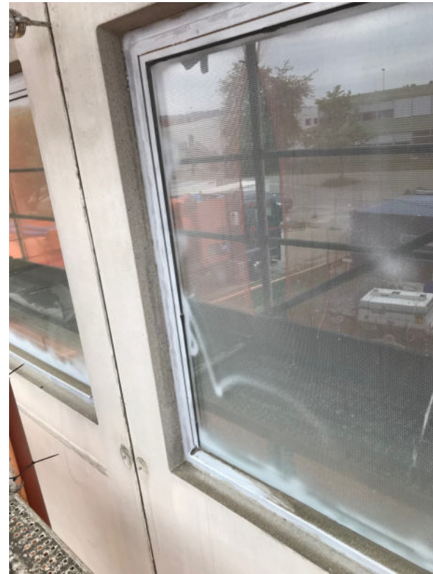
Entlackung der Fenster durch Sandstrahlen Erweitern der Entwässerungsöffnungen Erneuern der Fensterdichtungen Erneuerung und Aufarbeiten der Beschläge
