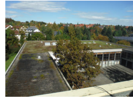
Dachfläche undicht
