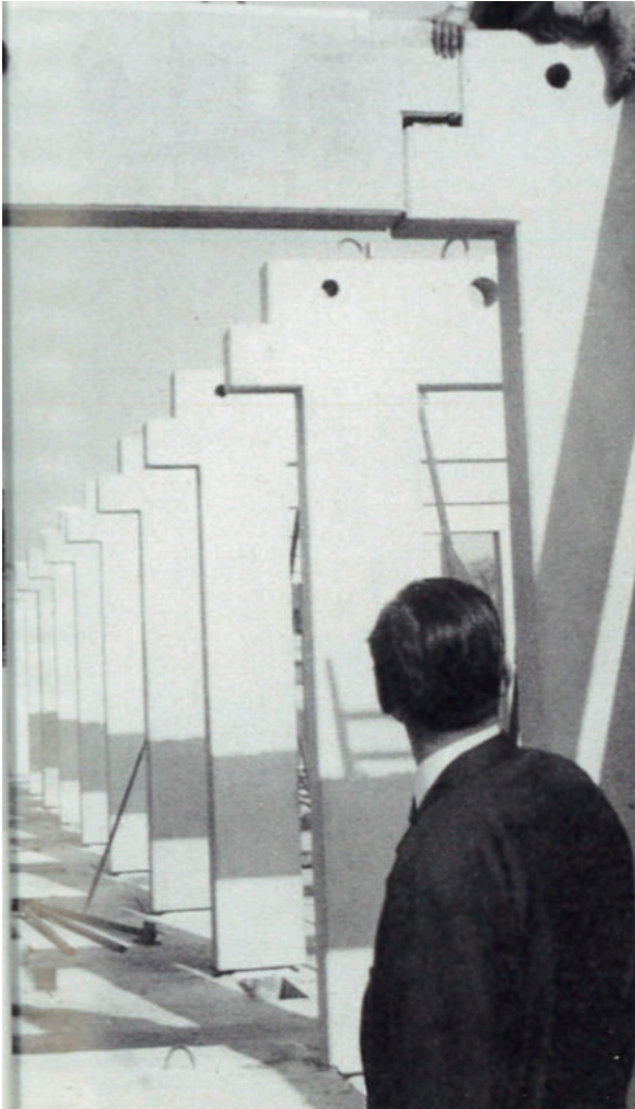
Montage der Querträger
