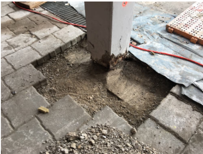
Freilegen der Decken und Stützenfüße
