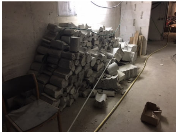
Kernbohrungen für neue Installationen
