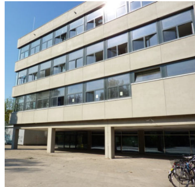
Generalsanierung Droste Hülshoff Gymnasium, Freiburg 2000-2009
