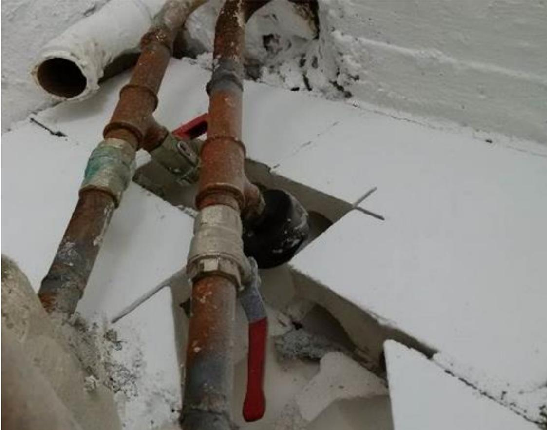
Für die gute Zugänglichkeit als auch für die Dämmarbeiten, sollen von Wand und Decke, aber auch untereinander Mindestabstände berücksichtigt werden. Die DIN 4140 nennt hierzu einen Zwischenraum von mindestens 100 mm.
