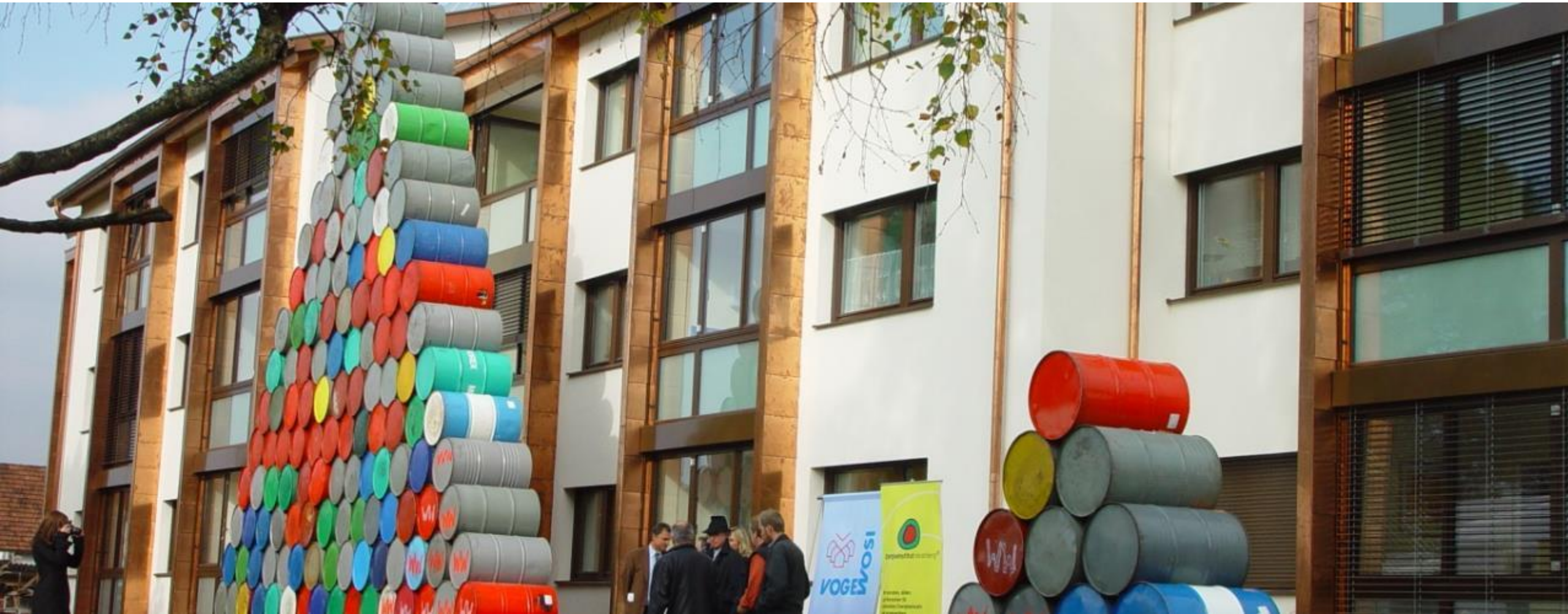
Sanierung Wohnanlage in Rankweil, Arch. A. Vogel-Sonderegger; Foto: M. Ploss
