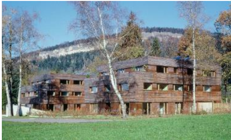
Arch. H. Kaufmann (oben), Arch. G. Zweier (unten) Fotos: Energieinstitut Vorarlberg
